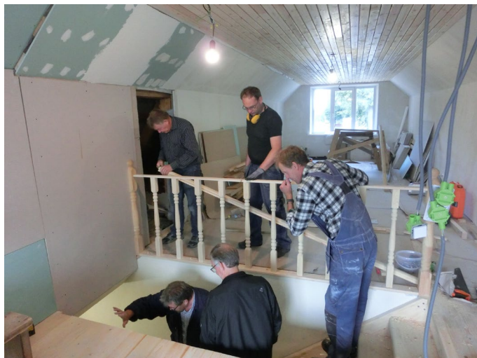
Tak, golv och räcke på plats.
